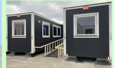
ムービングハウス（輪島市完成例）
